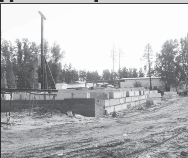
Строительные работы на Промышленной идут полным ходом
