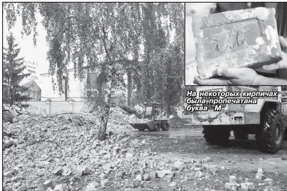
Труба упала в подготовленный для нее створ, даже не повредив деревьев
