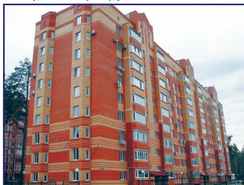
Дом №10 А на улице Славского
