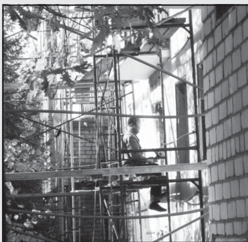
Теперь за счет федеральных средств не удастся ни стены утеплить, ни пластиковые окна установить
