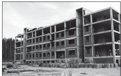
Работы на центре медрадиологии идут полным ходом
