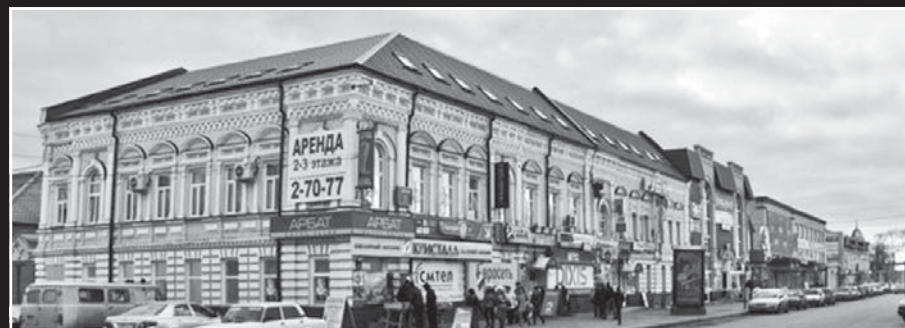
Старинные здания в центре города залеплены разномастными вывесками
