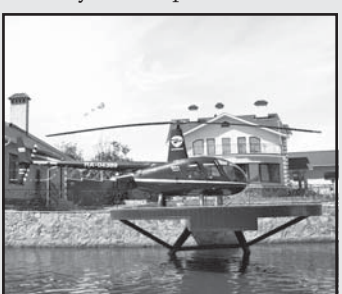
Вертолетная площадка построена прямо на воде, рядом с виллой
