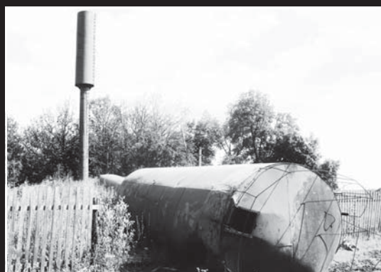
Во время падения конструкция деформировалась
