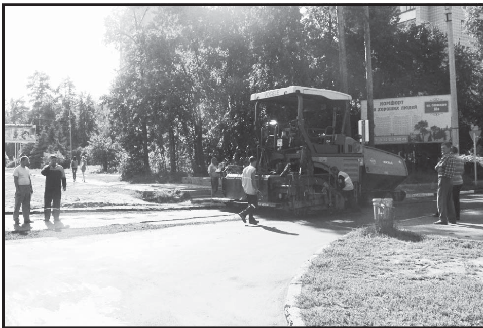
Движение по дорогам на время работ не перекрывается
