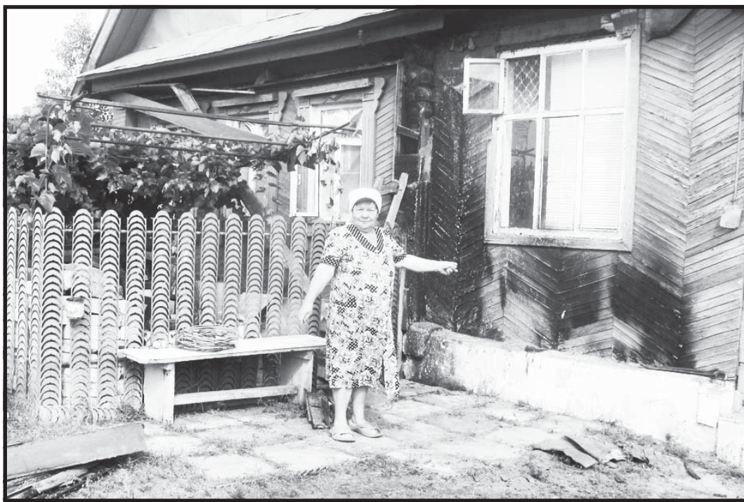
Теперь Ивановым придется искать деньги на ремонт дома
