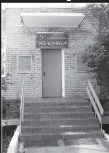
Детский сад подпоясали металлическим ободом
