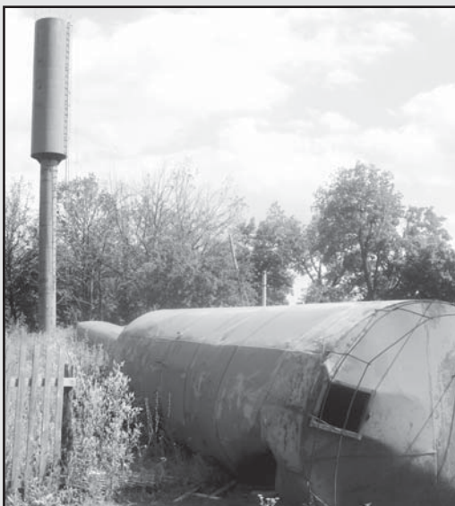
Упавшая конструкция уже проржавела
