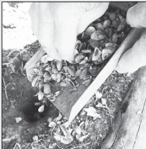
Шурф заполняется ракушечником - это отличный дренажный материал
