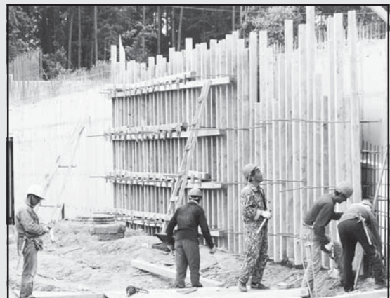
Турецкие строители выполняют самую сложную часть работы
