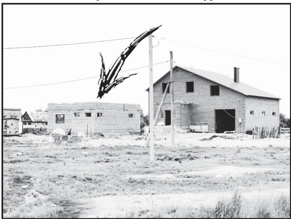
ЧП произошло в недостроенном коттедже в Енисейском переулке
